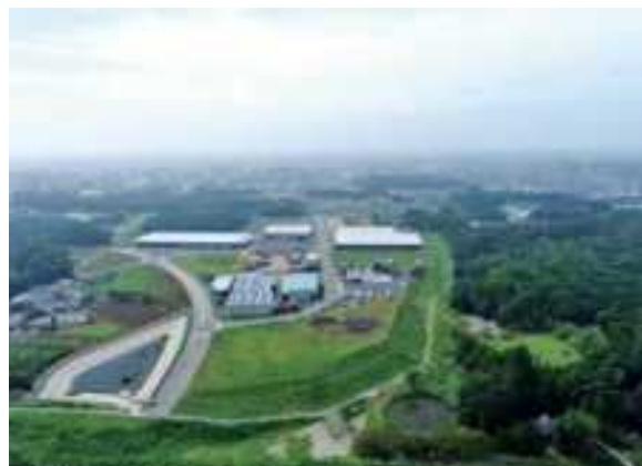
仁連工業団地(古河市) (令和4年8月)
