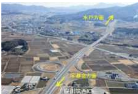
北関東自動車道桜川筑西IC 出典：茨城県ホームページ
