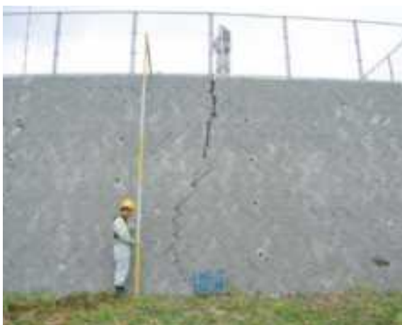
常磐の杜団地調整池（水戸市）
