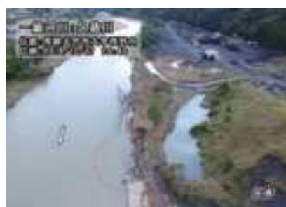
災害調査(UAVにより撮影)
