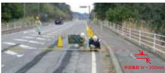
主要地方道大洗友部線(大洗町)
