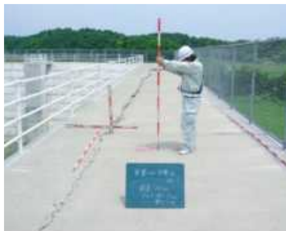
常磐の杜団地調整池（水戸市）
