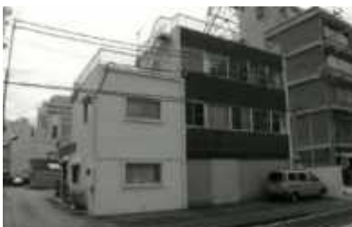
移転先の佐川ビル(昭和43年～昭和45年)
