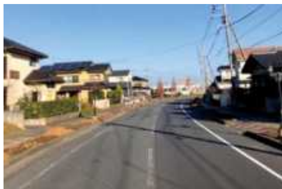
ひたちなか市神敷台地区 和田町海浜公園線 平成6年完成
