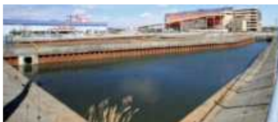
水戸市内原北地区 平成26年完成
